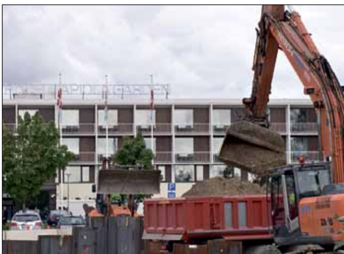
Metron ajorampin rakentamista Tapiolassa. Kuva: Esa Kivivuori.
